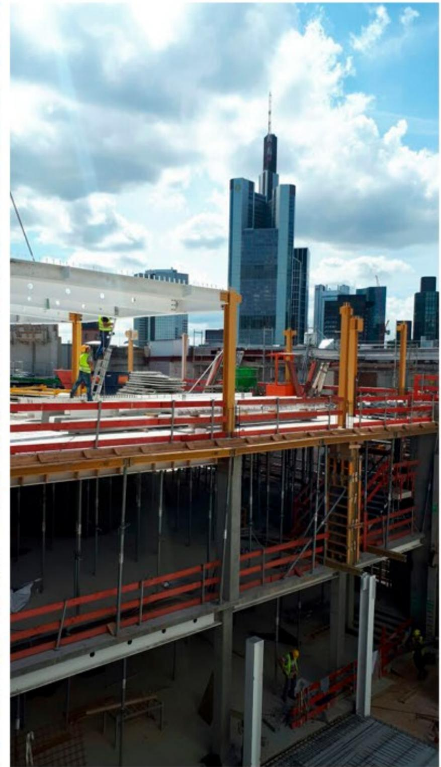
Bild 1: Vormontierte Wand des 4. und 5. Obergeschosses
