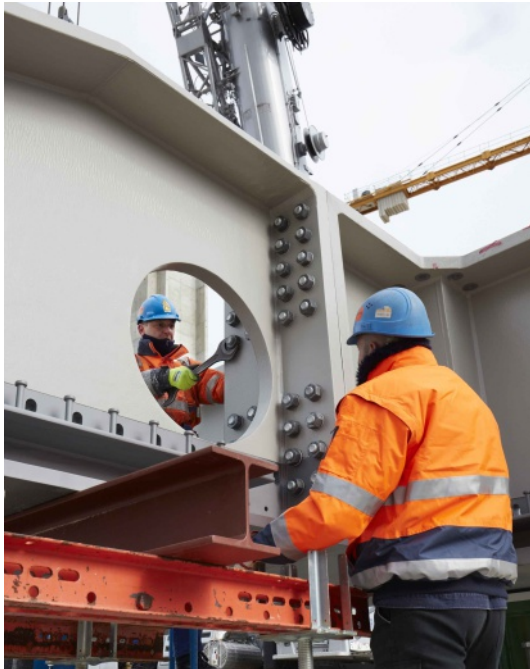
©ARGE WoS Stahlbau (Züblin Stahlbau GmbH und stahl + verbundbau gmbh)
